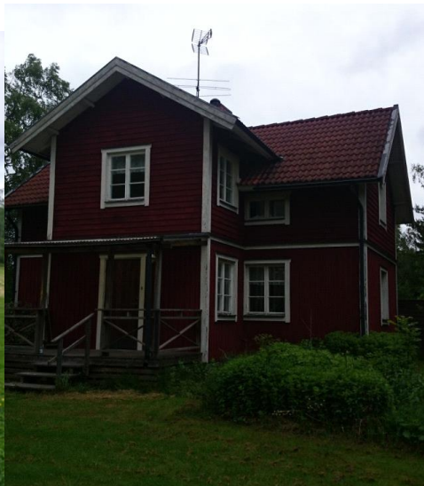
Befintlig äldre byggnad
